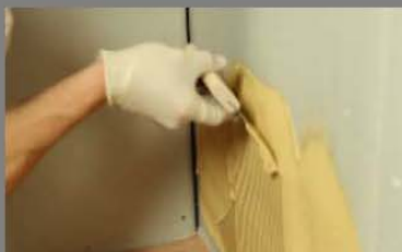
(5) 依现场情况请先将施工面找平，以便铺装均匀
